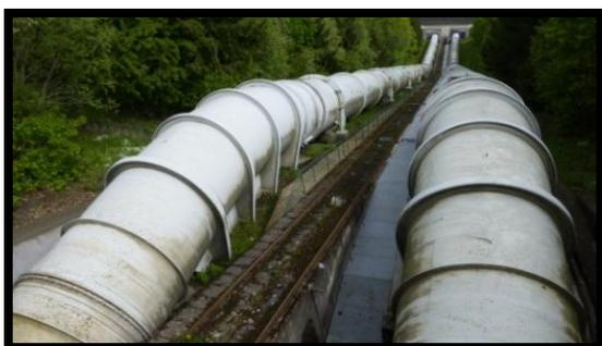
Si on poursuit la visite alentours, petit intérêt ferroviaire aux abords du barrage : une voie d'un petit écartement a été installée entre les deux conduites forcées dévalant la montagne où un petit engin ferroviaire de 14
